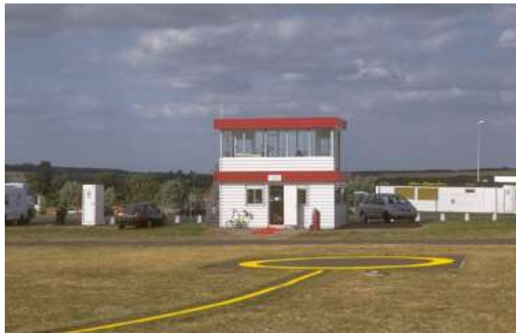
Voie de circulation sur le circuit de Nevers Magny Cours (photo STAC © Alexandre PARINGAUX / DGAC – STAC)
